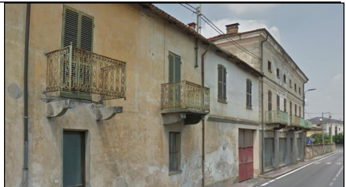
Vista del fabbricato recente intercluso lungo la v. Matteotti
