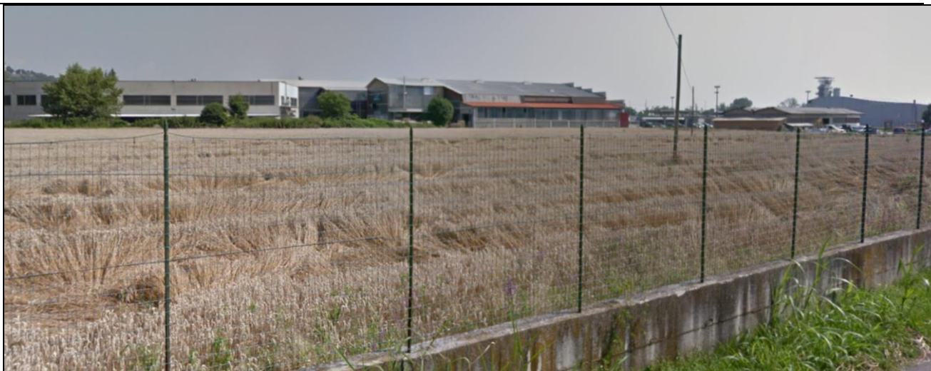
Vista ravvicinata stabilimento esistente da Via Vallera Sottana
