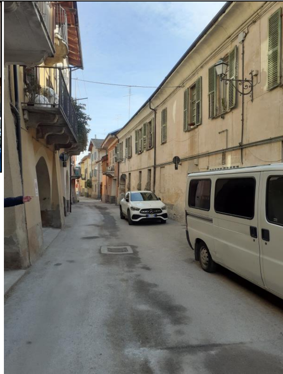
Vista stesso edificio dal lato della retrostante v. Brofferio
