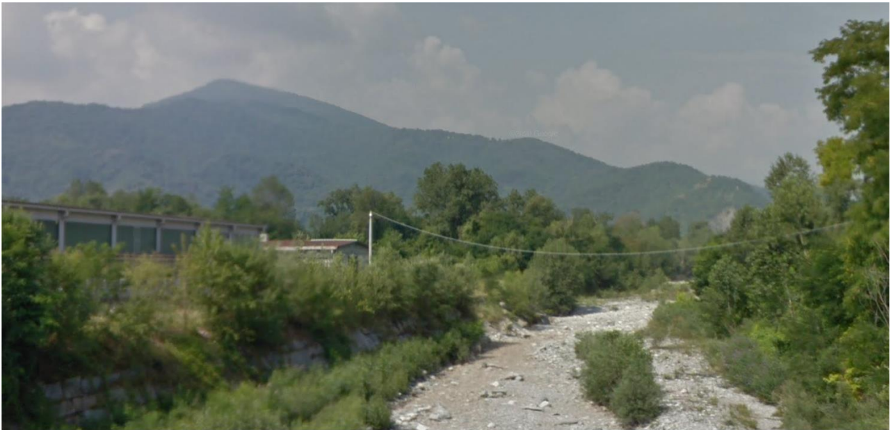
Vista da nord del retro dell'ambito produttivo dal ponte sul t. Grana
