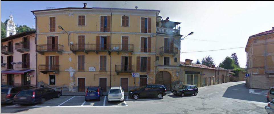
Vista fabbricato lungola p. Cavour e v. Cappuccini
